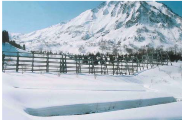
(新潟県糸魚川市柵口 昭和61年1月 雪崩発生13名が死亡 対策工後の写真)
